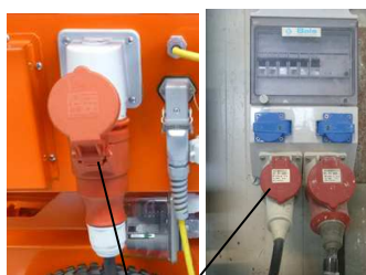
Рис. 25: Подключение электропитания 230 В ПЧ
